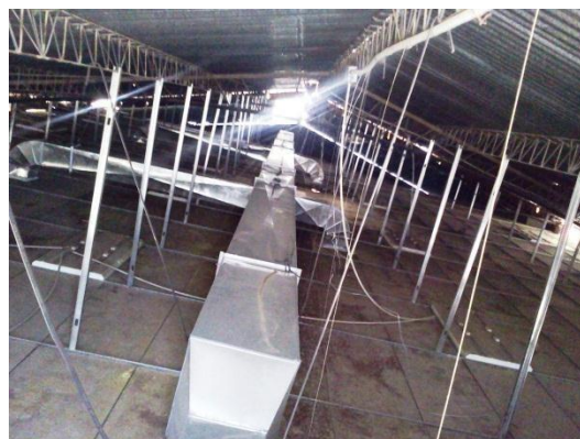
transporte neumático(colectores de aserrín) 2011 Feicobol
